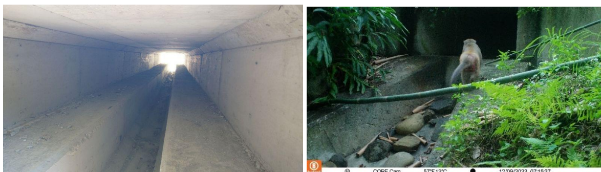
圖四、平廣路過路排水廊道及台灣獼猴進入排水涵洞動物廊道
