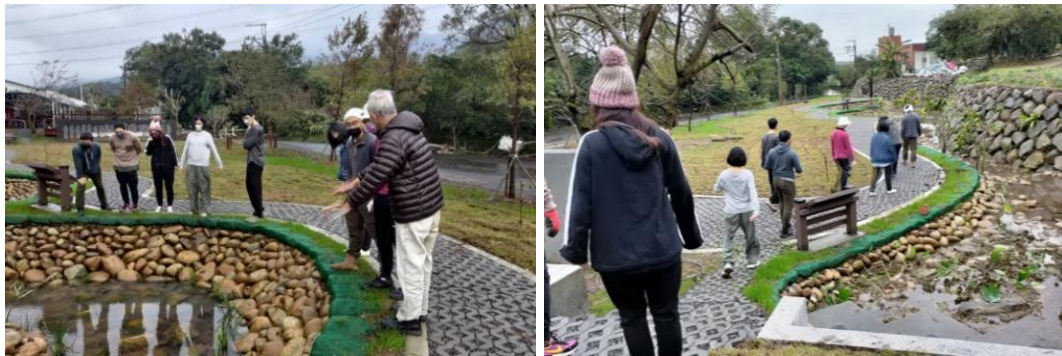
圖一、忠寮社區魚菜共生工程修築兩側邊坡，改善原有通水斷面及池內污濁水質，保育水池內原有生態並修築 S 型導覽步道
