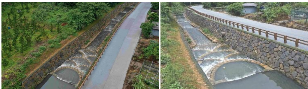
圖二、林口溪上游支流災害復建工程採用漿砌石生態工法，除提昇環境景觀及安全，也營造生態友善環境，創造生態、防洪、景觀三贏之工程優質永續環境
